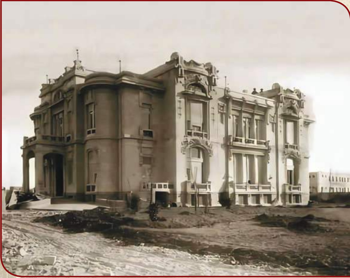
شكل ٣٢: قصر الزعفران أثناء البناء (١٩٠٢)، الجانبان الشمالي والغربي
