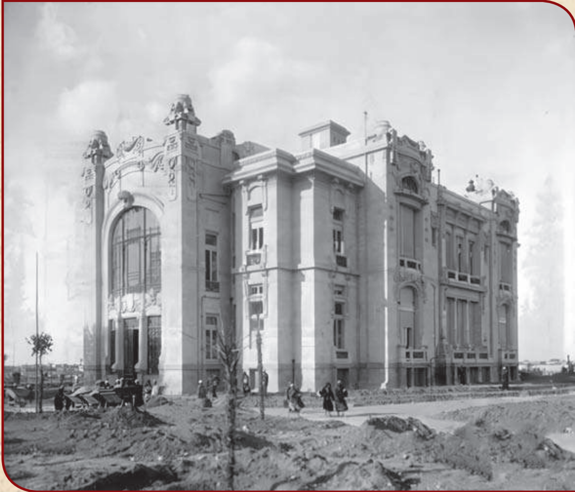
شكل ٣٣: قصر الزعفران أثناء البناء (١٩٠٢)، الجانبان الجنوبي والشرقي، ويشاهد عمال البناء أمام القصر
